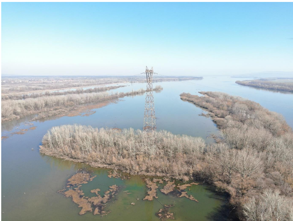
Slika 10: Pregled stuba na teško pristupačnom rečnom ostrvu
