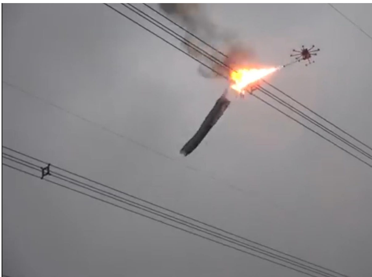
Slika 10: Primena bacača plamena za skidanje prepreke sa dalekovoda [2]
